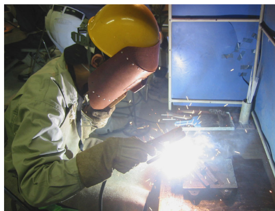
図 1 アーク溶接を行っている受
